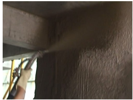
图4.5-7 修补不平墙体及螺杆洞
