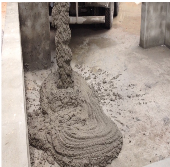
图4.1-1 现场搅拌砂浆
