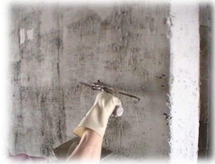
图4.5-7 修补不平墙体及螺杆洞
